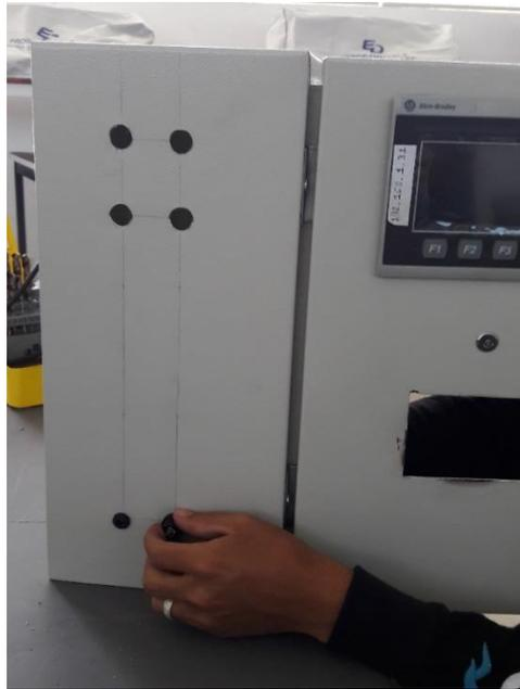
**Figura 21.** Colocación de los fusibles y de los porta fusibles, en el gabinete.
